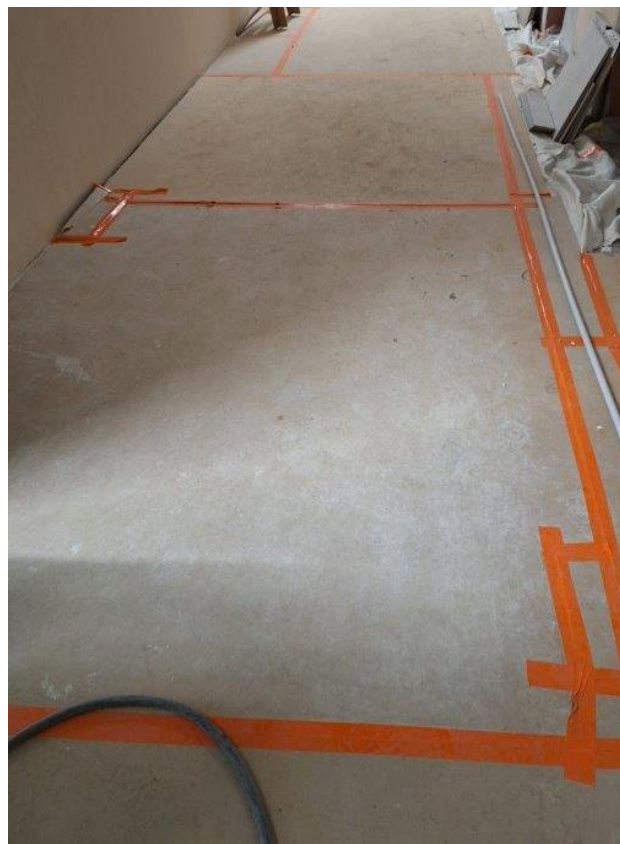
Důsledná ochrana hotových prací OSB deskami
