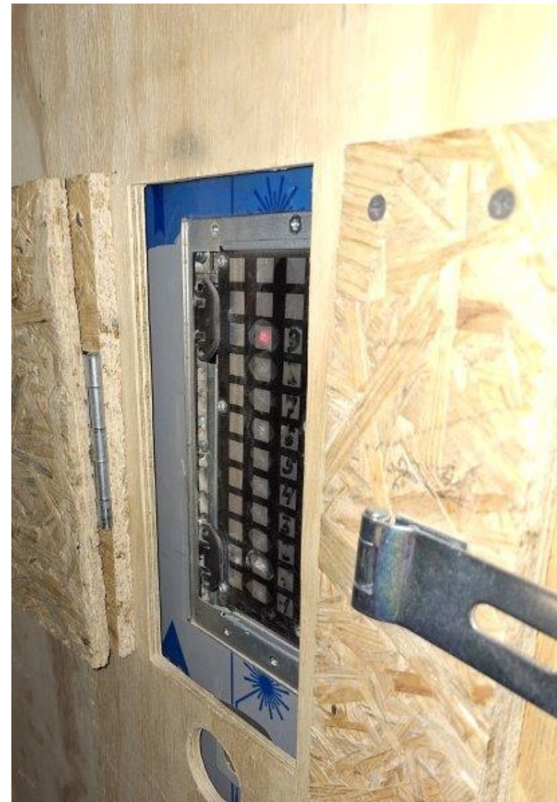
Ochrana interiéru výtahu používaného stavbou
